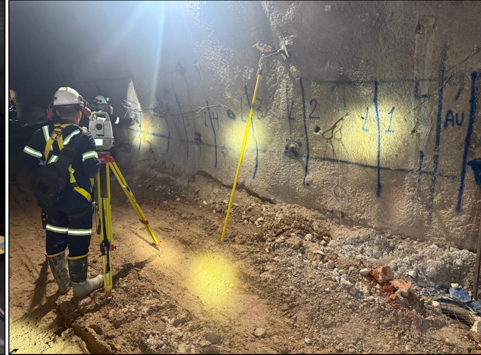
Marcaje topográfico de secciones
