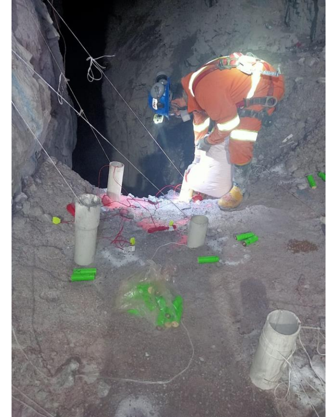
Cargado de barrenos (apertura del slot)
